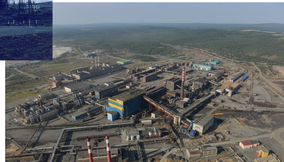
Среднеуральский медеплавильный завод в г. Ревда
